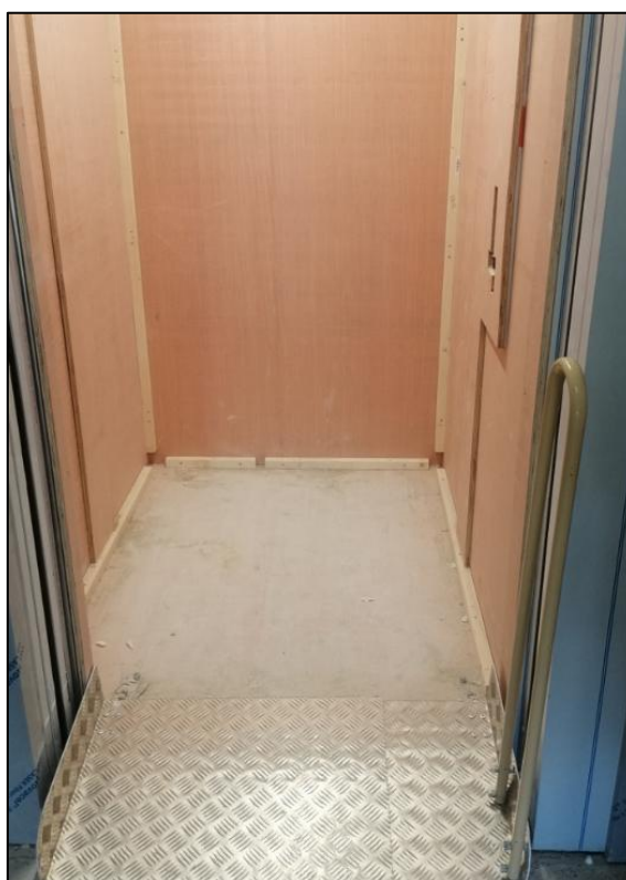
Figure 5 : Protection de chantier - ascenseur
